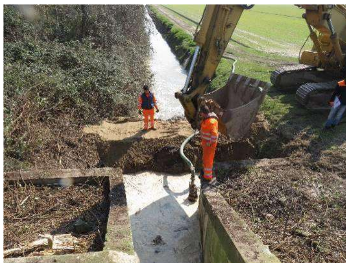
Figura 27. Fase di sostituzione di una chiavica
